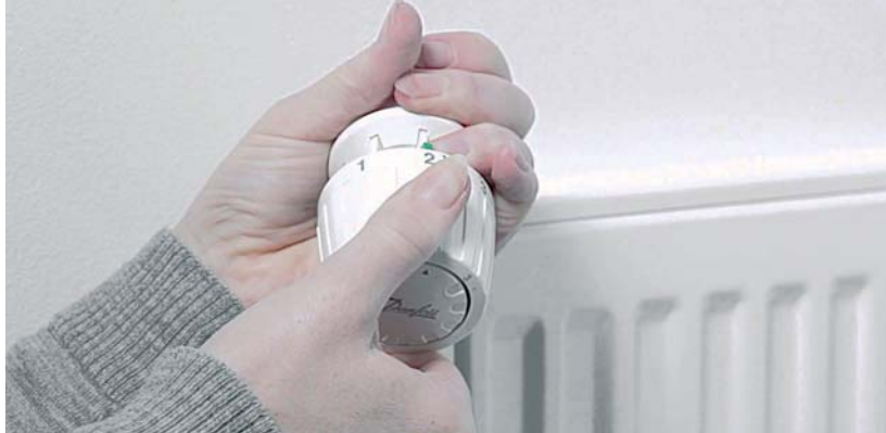
Рис. 8. Автоматичний радіаторний терморегулятор прямої дії
