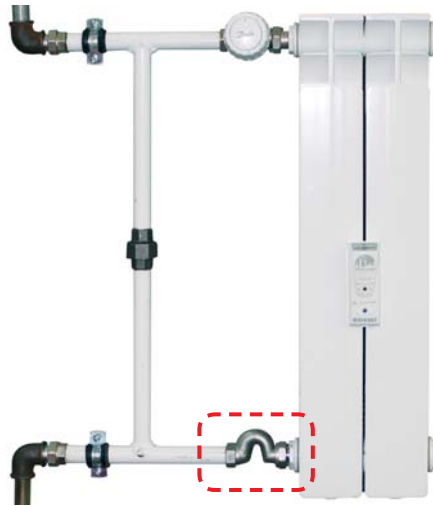
Рис. 10. Дросель зворотного потоку RTD-CB
